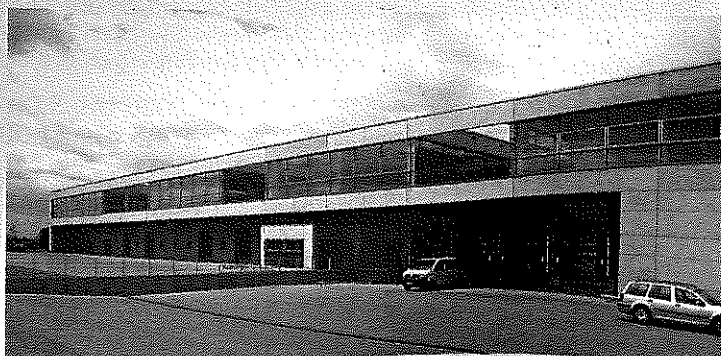
Juli 2006: Der Neubau des Pharmagroßhändlers Fiebig geht zielstrebig in die Vollendung
